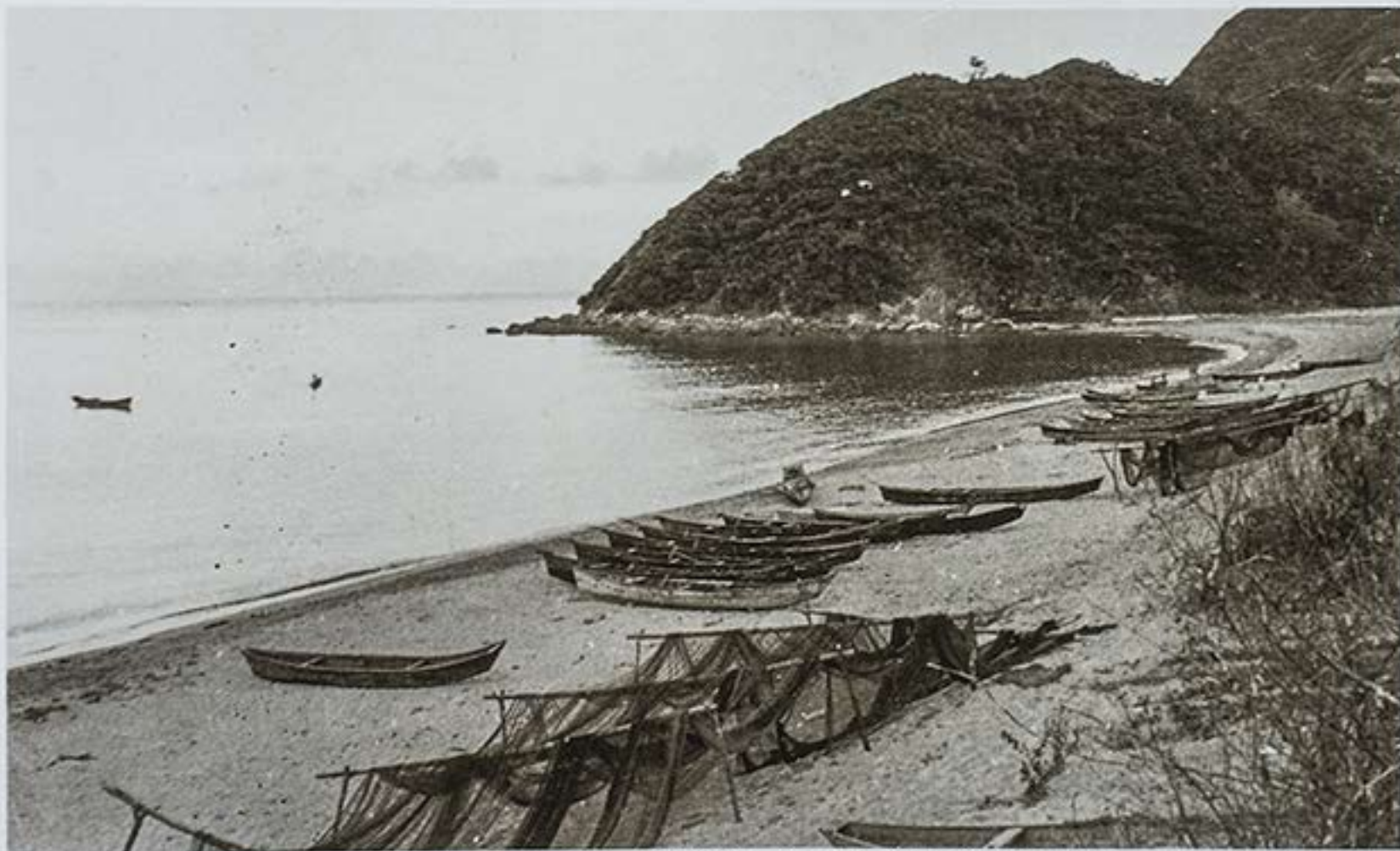
昭和30年頃 名瀬市小湊のナトの浜。昭和36年、第二室戸台風で海岸線が崩れ、護岸工事が行われた。 【提供】隣 重俊（名瀬市）
