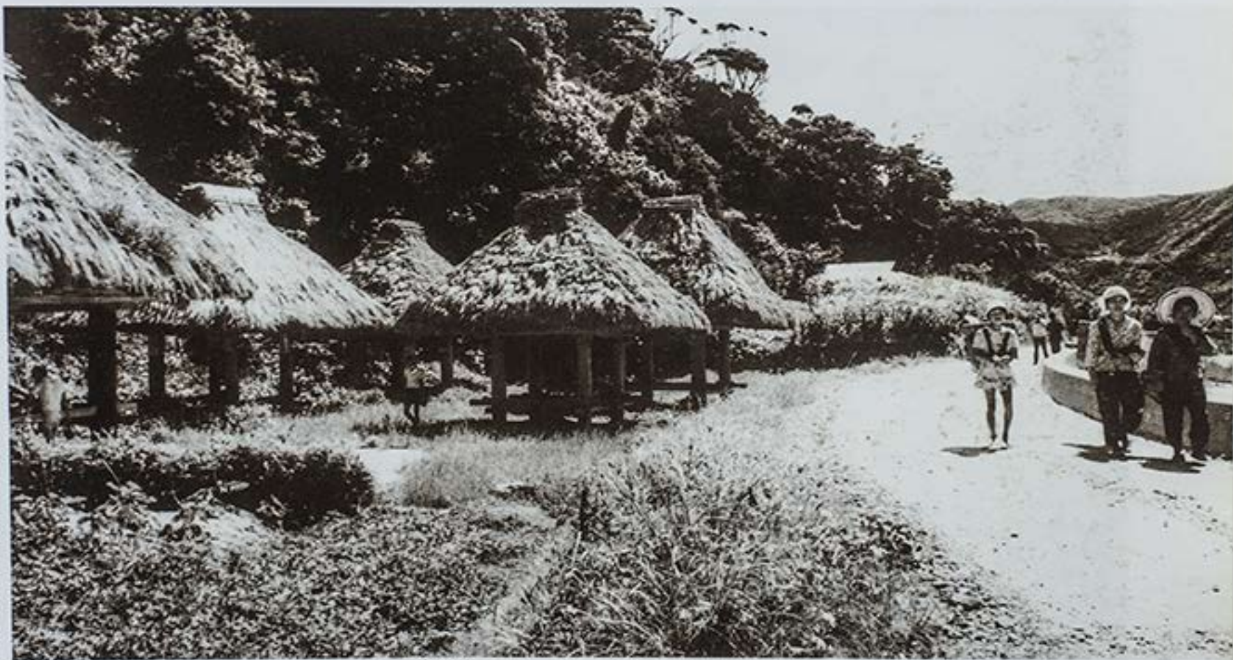
昭和46年 大和村大和浜の群倉(高倉群)。現在、道路は県道名瀬瀬戸内線として整備されており、その横に群倉 を見ることができる。高倉は群島全域で見られ、穀物等を湿気やネズミなどから防ぐ構造となっている。
